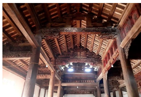
Hình 8. Chi tiết cấu kiện khung gỗ phía bên trong đình
